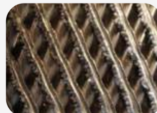
Circuit d'eau courante nettoyé
